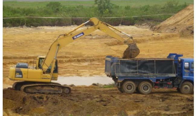
Đào xúc đất nhiễm bẩn trong khu vực lưu trữ
