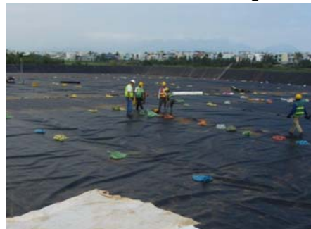
Lắp đặt lớp nhựa HDPE trên đáy sân phơi (Ảnh: CDM Smith)
