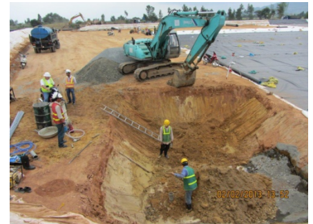
Thi công hồ gom trong sân phơi để thu gom nước (Ảnh: CDM Smith)
