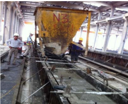
Đổ khối bê tông vào khuôn (Ảnh: CDM Smith)
