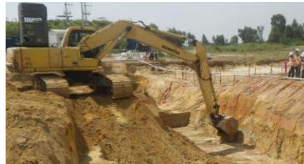
Đào xúc từ Mương Thoát nước trước đây (Ảnh: CDM Smith)
