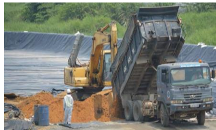
Đưa đất bị nhiễm bẩn Giai đoạn 2 vào khu tập kết tạm (Ảnh: CDM Smith)
