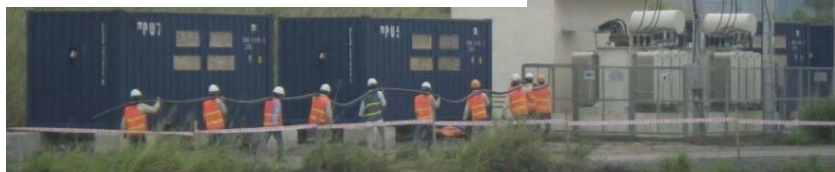
Giăng cáp điện
