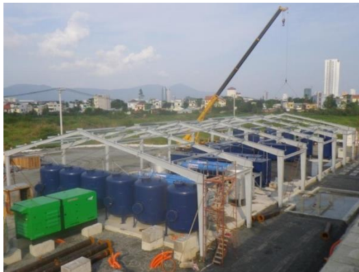
Lắp đặt hệ thống xử lý chất lỏng và hơi
