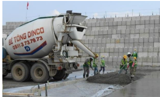
Xây nền của hệ thống xử lý chất lỏng và hơi (Ảnh: CDM Smith)
