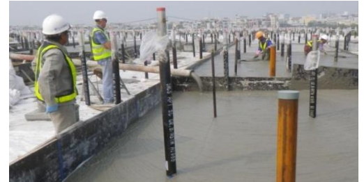
Đổ lớp bê tông phủ lên nóc móng xử lý (Ảnh: CDM Smith)
